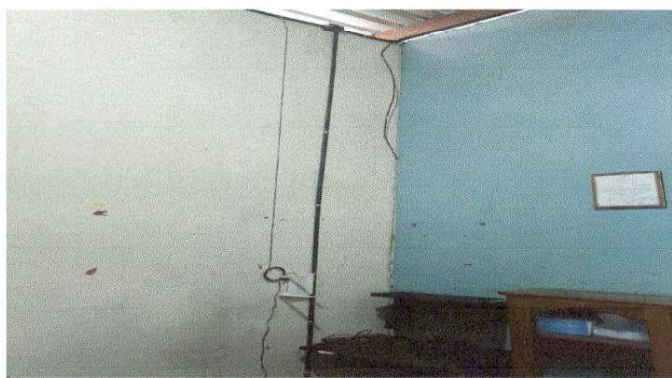
Foto 4: Finalización de instalación del cableado eléctrico
