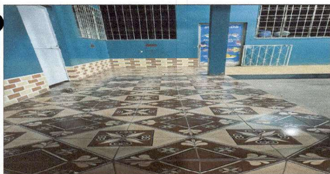
Foto 5: Finalización del piso cerámico
