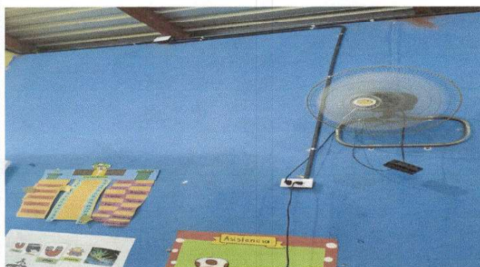
Foto 3: Finalización de instalación del cableado eléctrico
